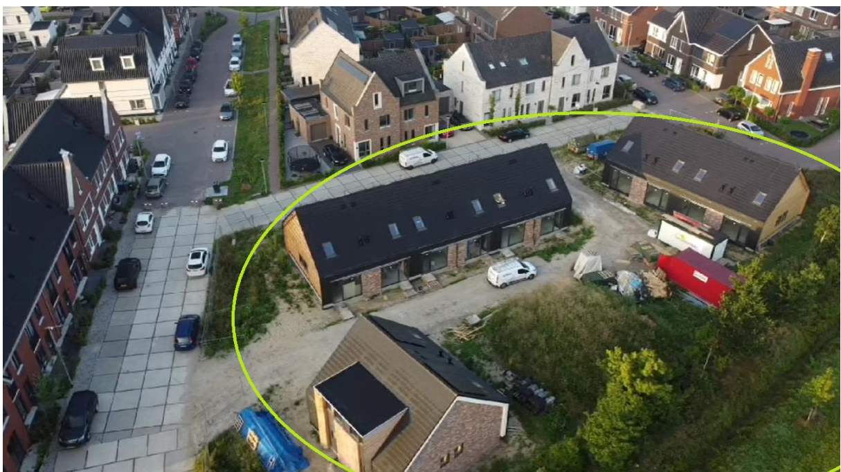
De 12 woningen van KlasseWonen Schuytgraaf in aanbouw, augustus 2023 (lichtgroen omlijnd)
