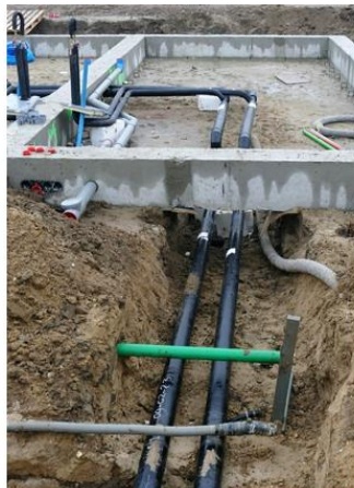
Februari: vloeren, kabels en leidingen
