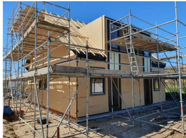
April: de eerste 2 woningen verschijnen, het hout is in de fabriek op maat gemaakt
